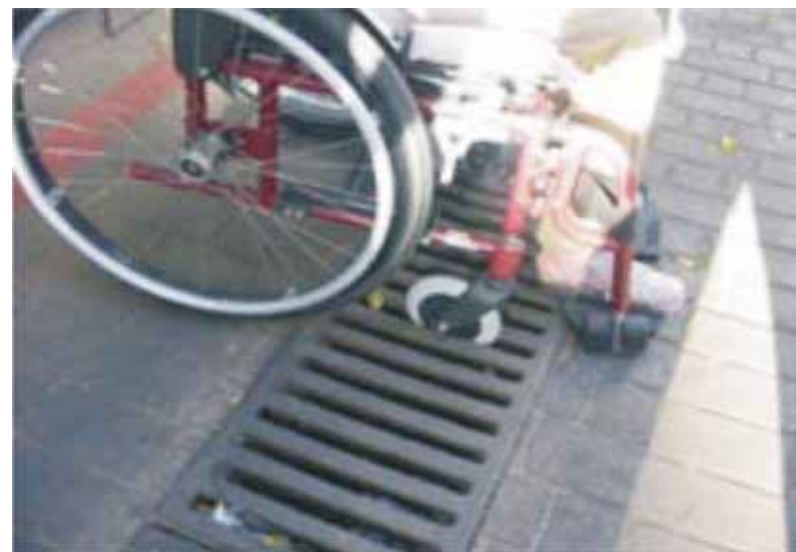
Foto 13: Exemplo de grelha inadequada. (Fonte: Brasil. Ministério das Cidades. Caderno do Programa Brasil Acessível)
