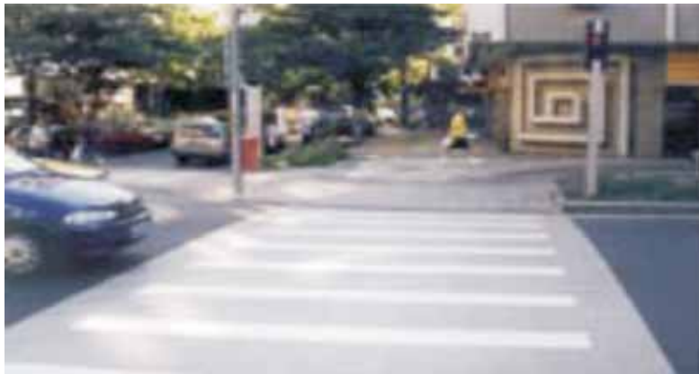
Foto 1: Exemplo de guia rebaixada junto à faixa de segurança. (Fonte: Brasil. Ministério das Cidades. Caderno do Programa Brasil Acessível)
