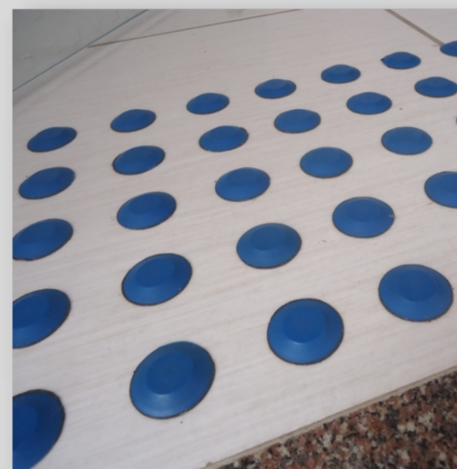
FOTO ILUSTRATIVA DO PISO TÁTIL PVC DISCREET MODELO ALERTA NA COR AZUL - INSTALADO EM ÁREA INTERNA
