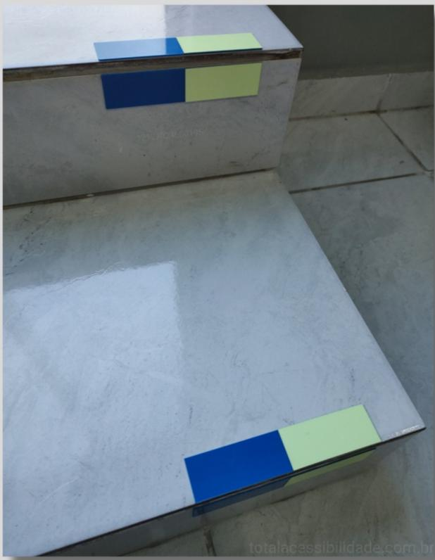
Foto ilustrativa da instalação do sinalizador de degraus fotoluminescente na cor **azul**, contrastando com o piso existente. O sinalizador de degraus azul é o sinalizador que mais se adequa a maioria dos LRV's dos pisos existentes.
