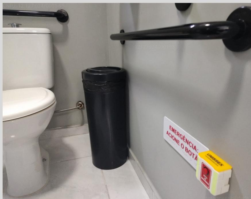
FOTO ILUSTRATIVA DO PRODUTO ALARME DE EMERGÊNCIA INSTALADO NO SANITÁRIO ACESSÍVEL UNISSEX
