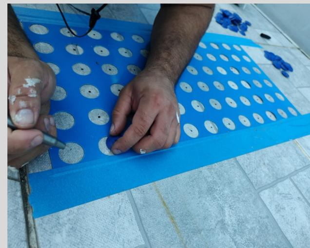
FOTO ILUSTRATIVA DA MARCAÇÃO DOS FUROS DO RELEVO TÁTIL PVC DISCREET ALERTA
