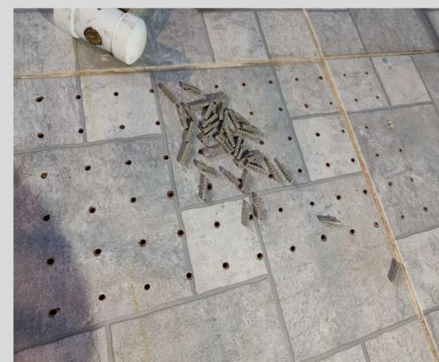
FOTO ILUSTRATIVA DA INSTALAÇÃO DAS BUCHAS DO RELEVO TÁTIL PVC DISCREET ALERTA
