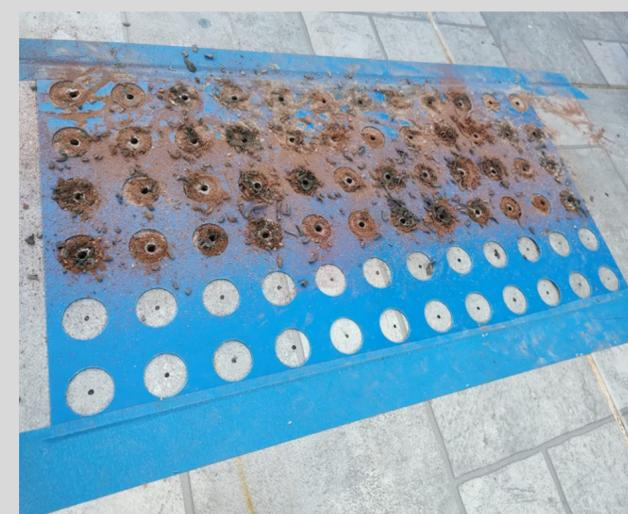
FOTO ILUSTRATIVA DAS PERFURAÇÕES PARA FIXAÇÃO DO RELEVO TÁTIL PVC DISCREET ALERTA
